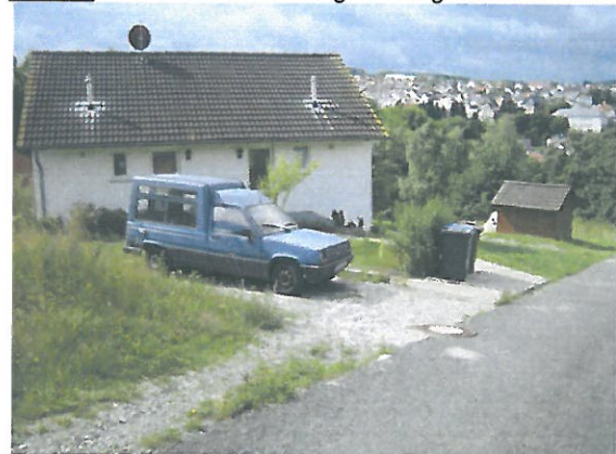
Foto 4: Blick auf die Bebauung Golfweg Nr. 3
