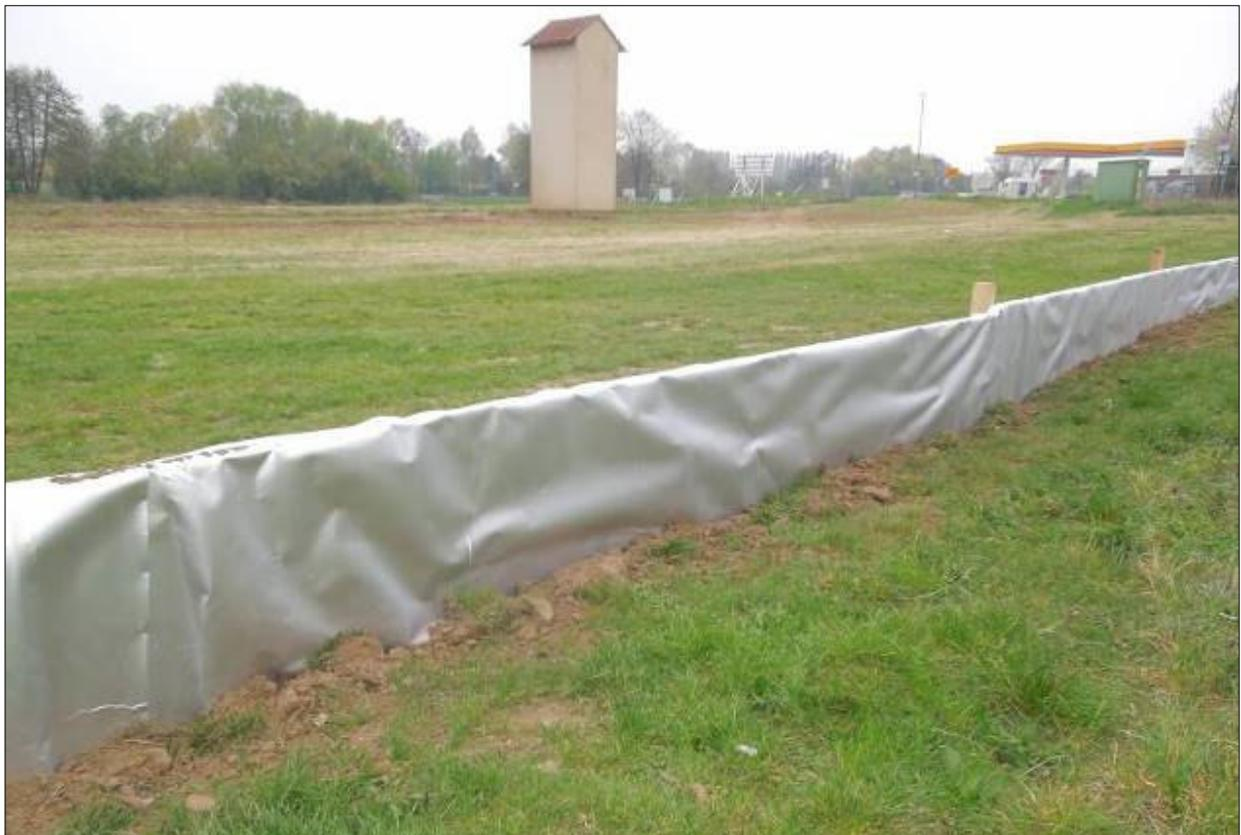
**Abb. 2:** Beispiel eines Reptilienzauns mit glatter Aluminium-PE-Folie.
