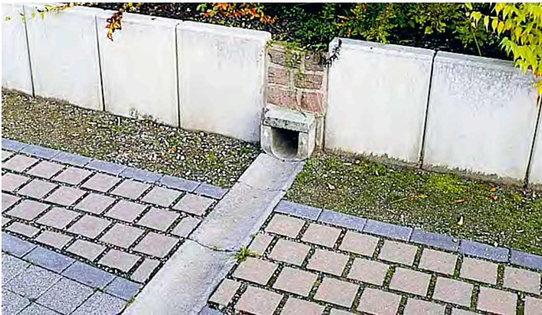
Abb.: Überlauf, Regenwasserspeicher in Mulde.
