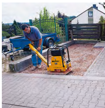
Abb. links: Verdichten der Fläche mit einem Flächenrüttler.
