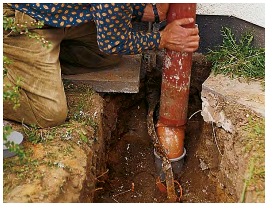
Abb. rechts: Anschluss an Hofablauf.
