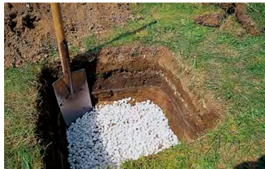
Abb. links oben: Ausheben der Grube.
