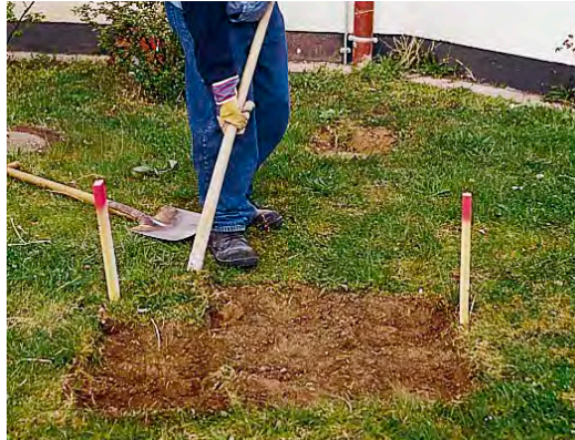
Abb. links: Abstecken der Baugrube.
