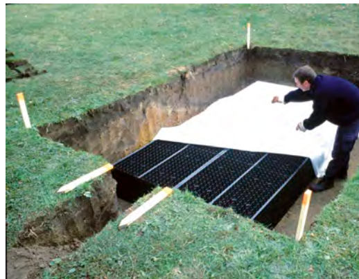
Abb. links: Einsetzen der Kunststoffelemente.
