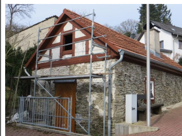
Das Backhaus wird in Eigeninitiative saniert – eine Toilette wäre schön
